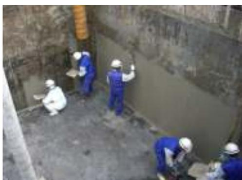
写真-12 コンクリート表面の補修
