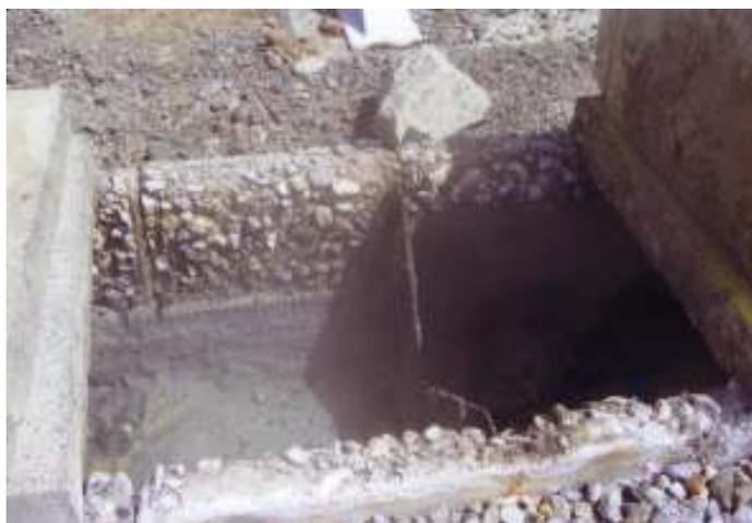
写真-5 強い酸により劣化したコンクリート製排水溝の状況
